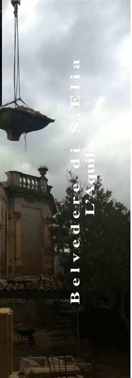
L'impresa, avvalendosi della consulenza di un team di progettisti specializzati in restauro, ha eseguito una cerchiatura del complesso manufatto a pianta ottagonale mediante l'applicazione di trefoli metallici, e, dopo la rimozione della cupola sommitale, ha provveduto alla copertura provvisoria.
